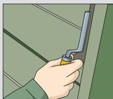
Für ein einheitliches Bild: Motivplatten mit Hebel ausrichten. Kleinere Abplatzer, „Schürfwunden“ und Haarrisse mit Spachtelmasse ausbessern. Fugen mit Fugenmörtel verfüllen und glätten.
