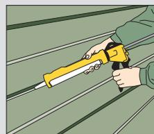
Für eine blickdichte und einheitliche geschlossene Optik werden die Zwischenräume der Plattenelemente mit Außenacryl versiegelt. Erforderliche Außentemperatur beträgt ca. 14°C.
