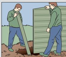
Zweiten Pfosten passgenau an Elementen ansetzen, lotgenau ausrichten und einbetonieren. Beton für zusätzliche Lastverteilung bis unter die Platten anfüllen.
